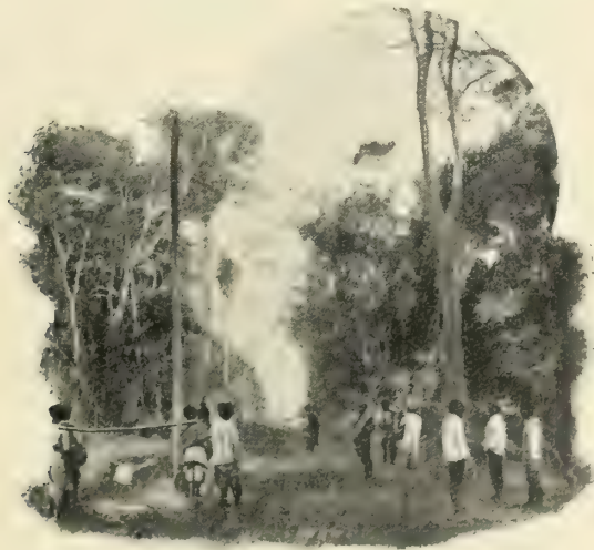
Fig. 87. — Construction du télégraphe.
